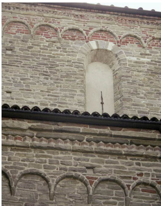
9. Acqui Terme, cattedrale. Cornice ad archetti pensili sul fianco nord: navata centrale e navata laterale.
